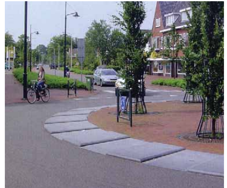
het hart van de rotonde is laag en kent geen verkeerstechnische verhoging, daarnaast zijn de banden van een antracietgrijs natuursteen materiaal
